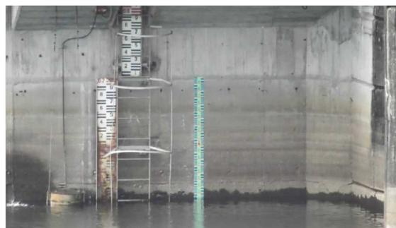
図1:実証実験の様子(量水板の設置)
